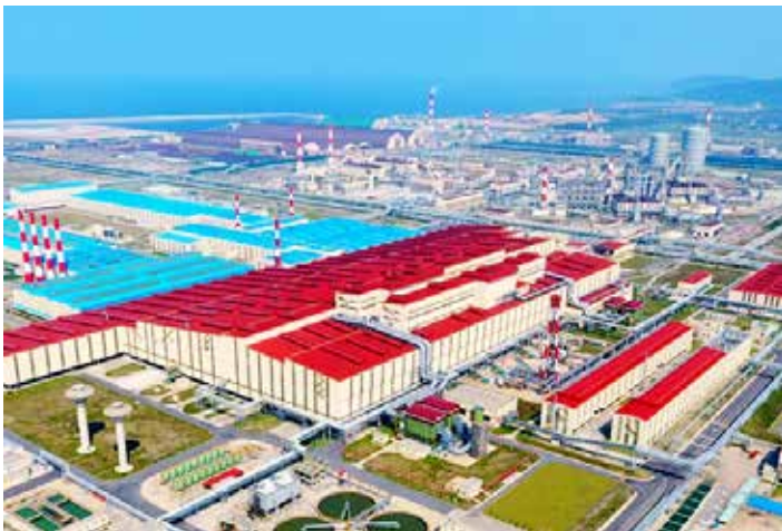
Nhà máy điện Công ty Formosa Hà Tĩnh Ha Tinh Formosa Electric Factory
