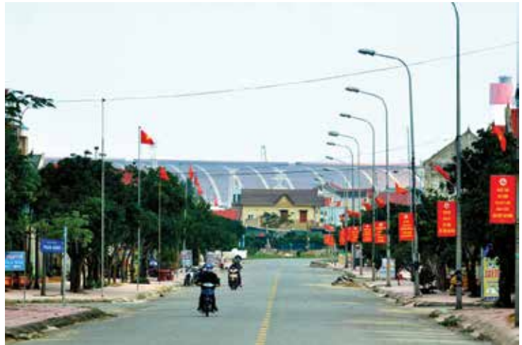
Hệ thống điện chiếu sáng tại tuyến đường Lê Quảng Chí, phường Kỳ Long Lighting system at Le Quang Chi street, Ky Long ward
