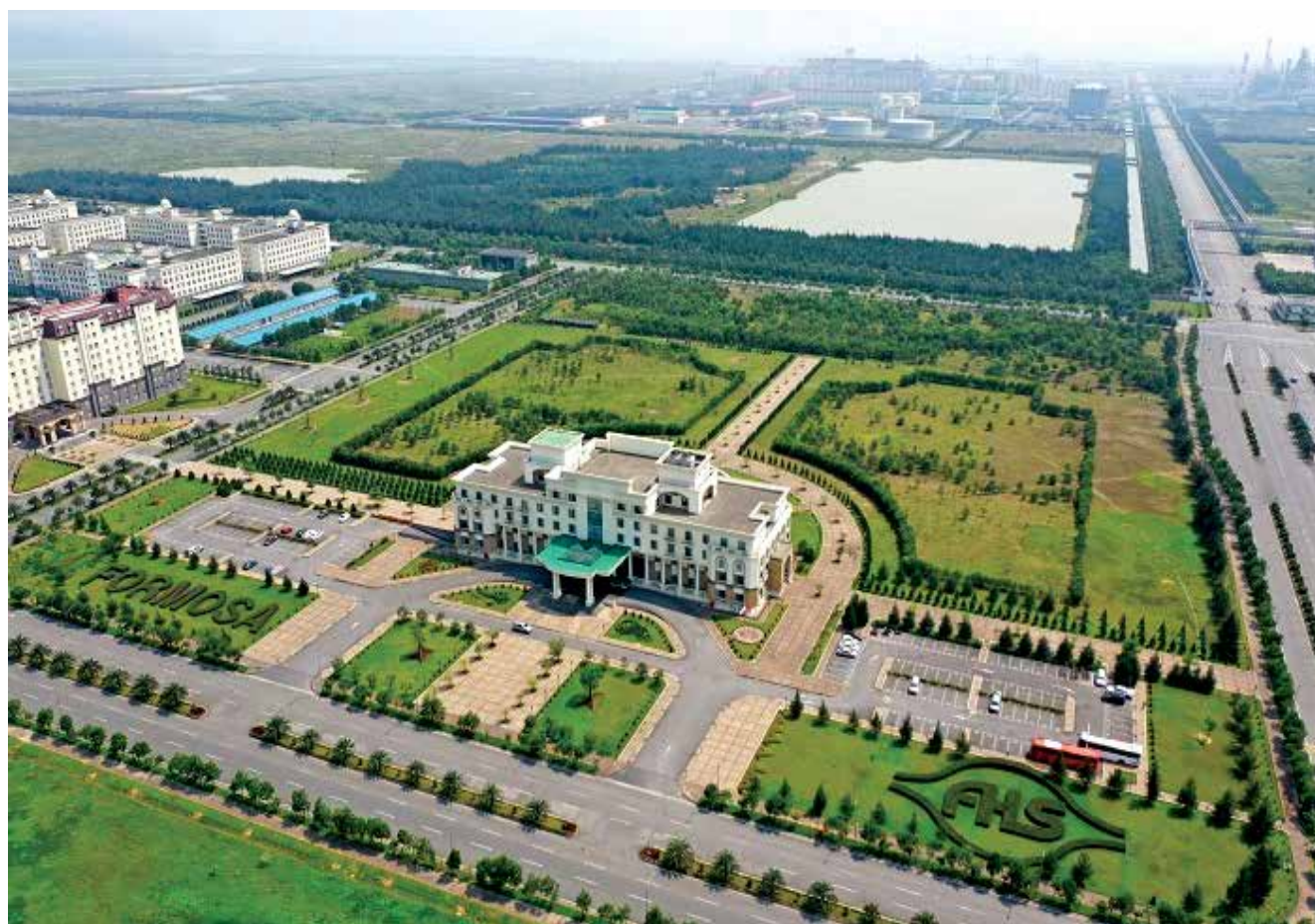
Khu hành chính - dịch vụ - thể thao của Công ty TNHH gang thép Hưng nghiệp Formosa Hà Tĩnh Administration - Service - Sports area of Formosa Ha Tinh Steel Corporation
